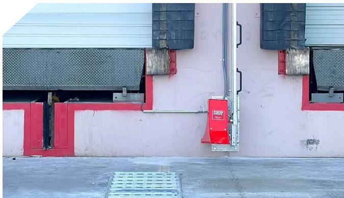
SGWS-Standort in Las Vegas – Installation im Jahr 2021-2.
