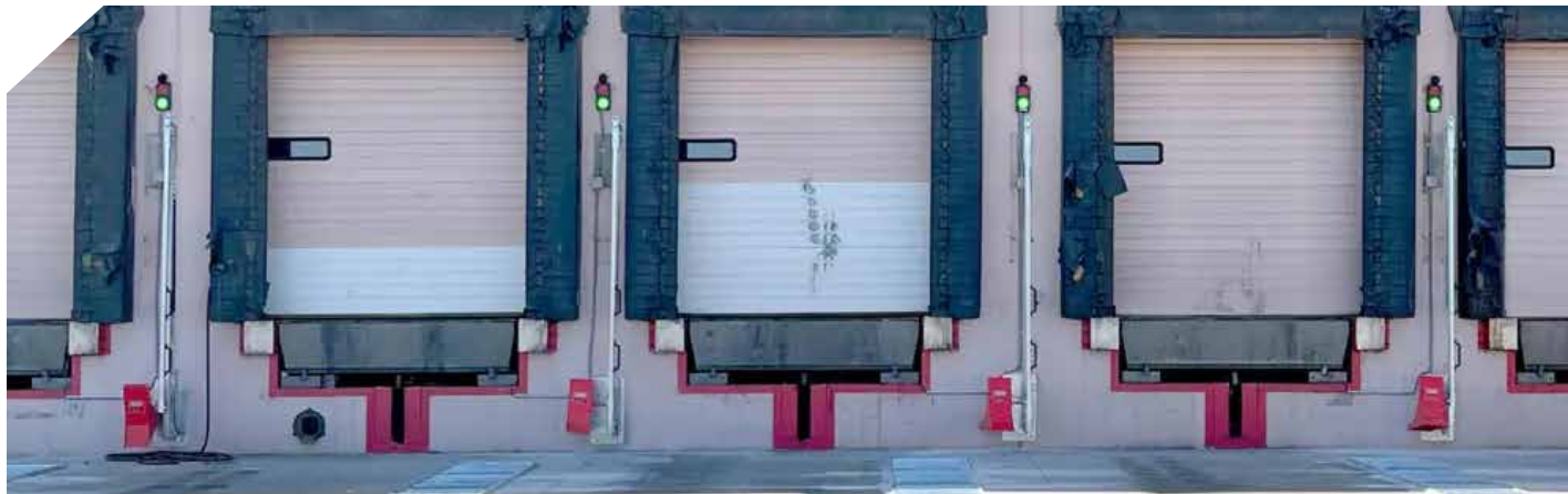
SGWS-Standort in Las Vegas – Installation im Jahr 2021.
