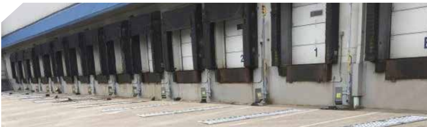
Verladerampen im SYSCO-Standort Pittsburgh (USA), gesichert mit POWERCHOCK-Radrückhaltesystemen
