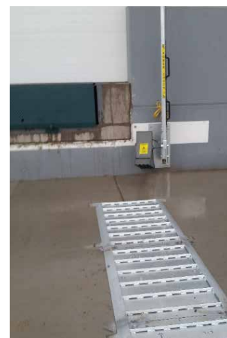
L'ancien modèle ergonomique POWERCHOCK 5 et le bras articulé en opération depuis plusieurs années.
